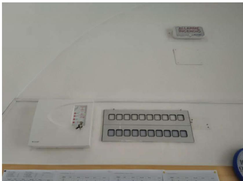
La verifica singolarmente di tutti i **pulsanti di allarme** dei vari **punti di controllo** (scatoletta e vetrino integro, loro funzionalità, segnalazione tramite idonei cartelli) saranno inseriti nel Registro dei controlli antincendio.
