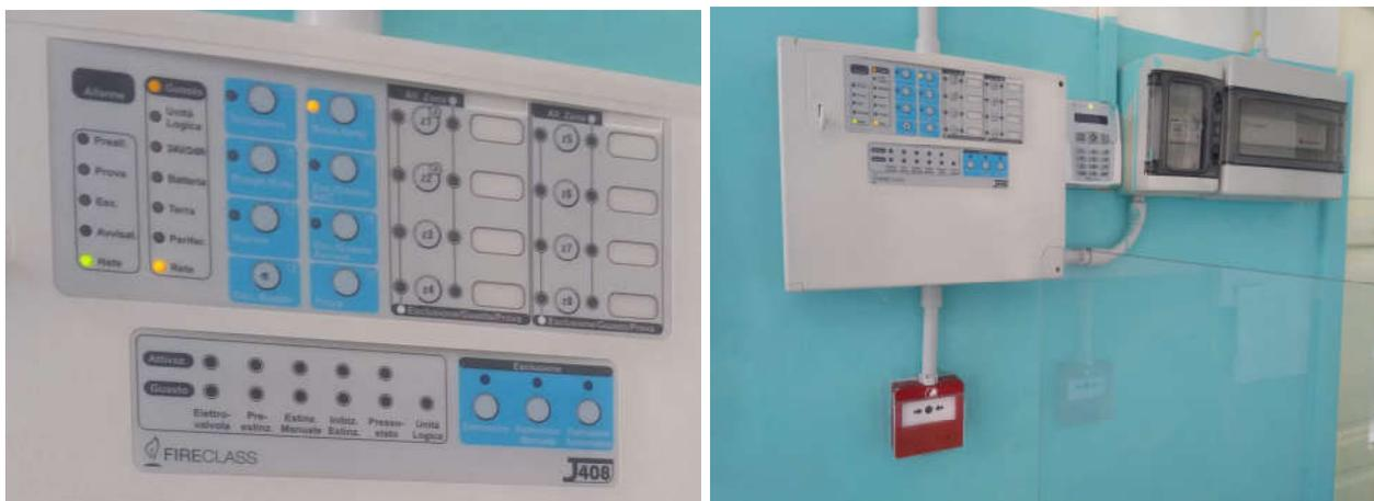
La verifica singolarmente di tutti i **pulsanti di allarme** dei vari **punti di controllo** (scatoletta e vetrino integro, loro funzionalità, segnalazione tramite idonei cartelli) saranno inseriti nel Registro dei controlli antincendio.
